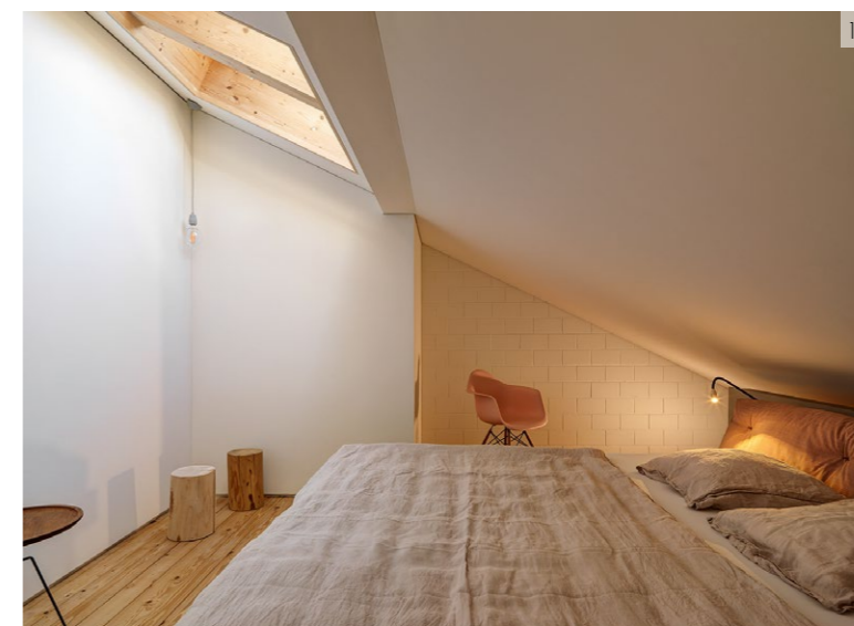
9 Das Dachgeschoss, wo zuvor eine Winde war, wurde ausgebaut und dient neu als Büro und Aufenthaltsraum. Das Deckentäfer wurde beim Umbau durch eine verputzte Decke ersetzt.
